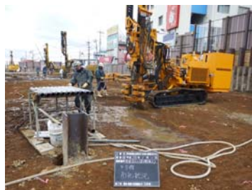
1) 地盤改良工事の様子
