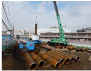
◆鋼管杭工事の様子
