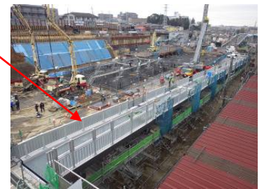
◆桁架設の様子
