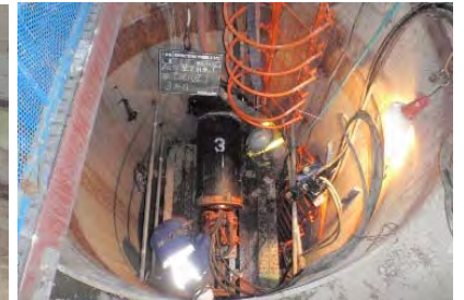
写真② 立坑内部
