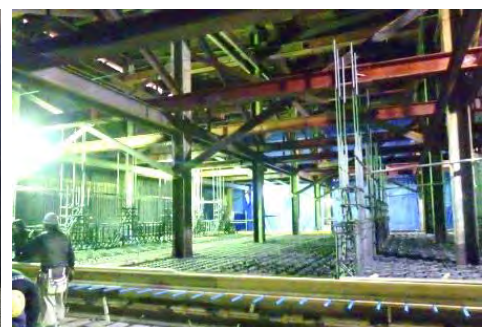
写真② 鉄筋の組立
