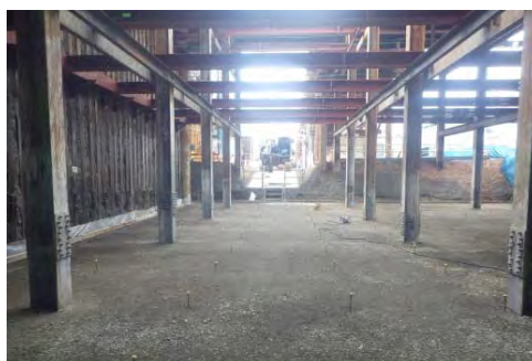
写真① 掘削完了後
