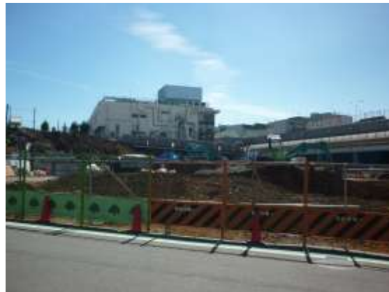
【区域東側解体工事の様子】
