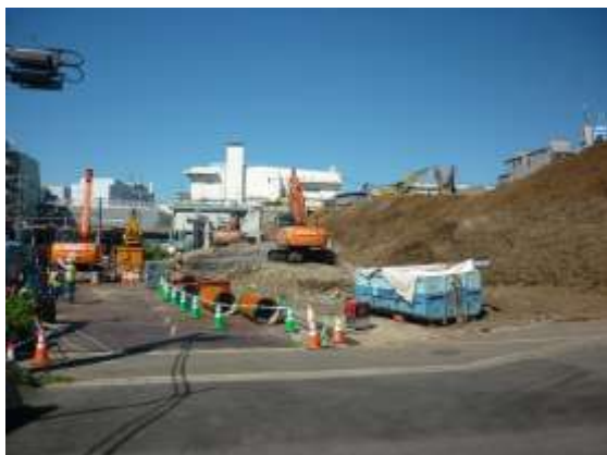
【区域西側解体工事の様子】
